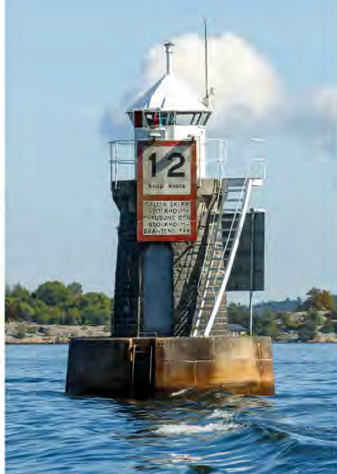
Этот маяк недалеко от Стокгольма был установлен в 1912 г. Когда в 1980 г. маяк был электрифицирован, стало понятно, что солнечный клапан непрерывно работает с 1912 г. и не требует ремонта
