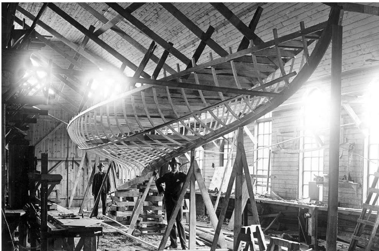
Постройка шхерного крейсера «Marga III» (95 м 2 ), 1917–1918 гг. Длина 18,3 м, ширина 2,8 м, верфь Stockholms Motorbetsvarv, конструктор Эрик Саландер
