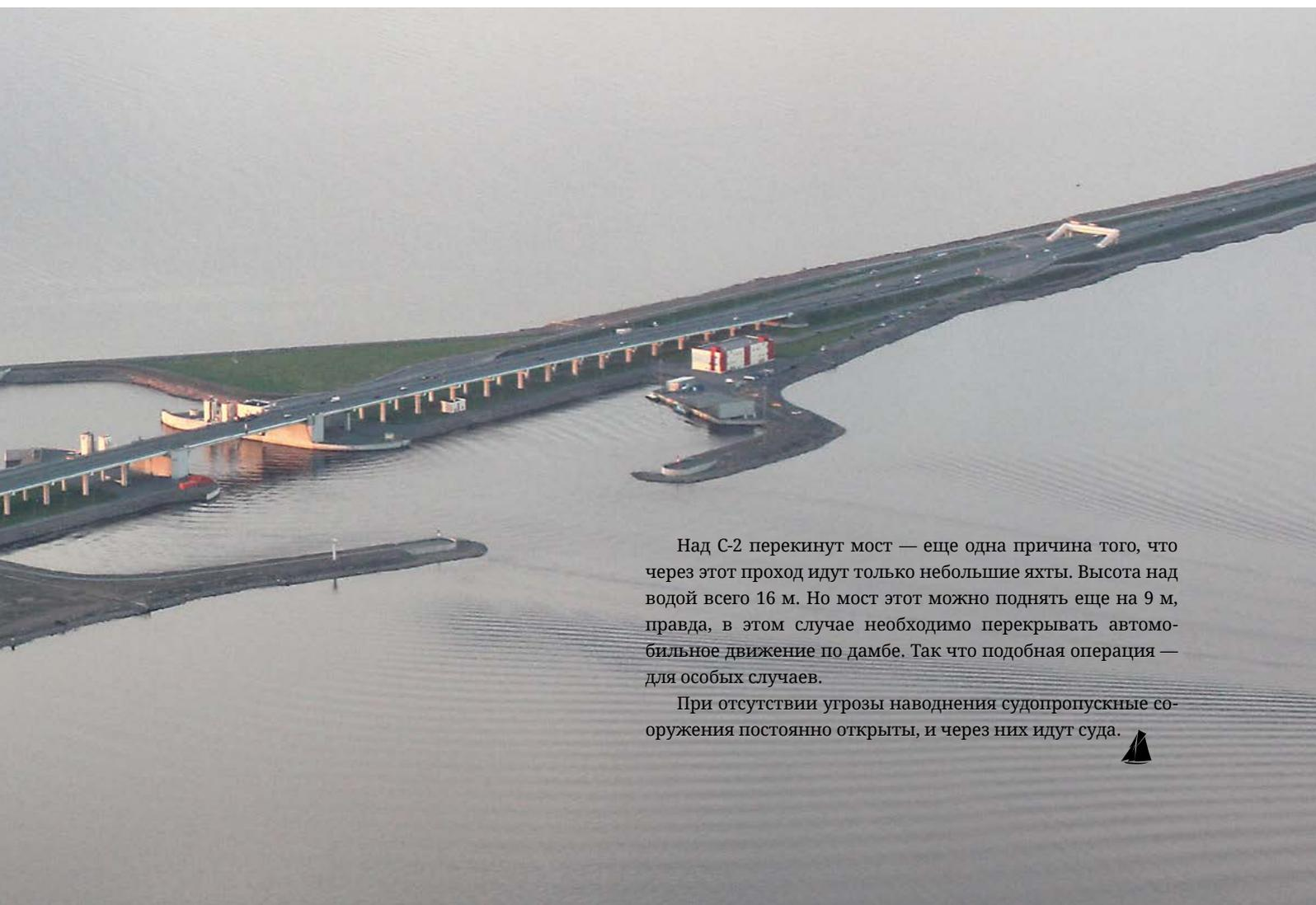
Над С-2 перекинут мост — еще одна причина того, что через этот проход идут только небольшие яхты. Высота над водой всего 16 м. Но мост этот можно поднять еще на 9 м, правда, в этом случае необходимо перекрывать автомобильное движение по дамбе. Так что подобная операция — для особых случаев.
